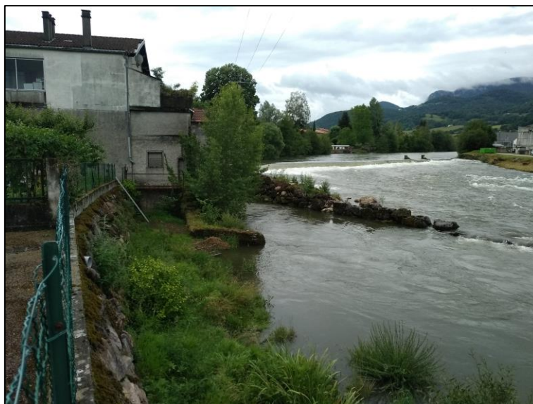
Figure 4 : Vue de l'état actuel des berges aménagées en amont (haut) et en aval (bas) du futur seuil
