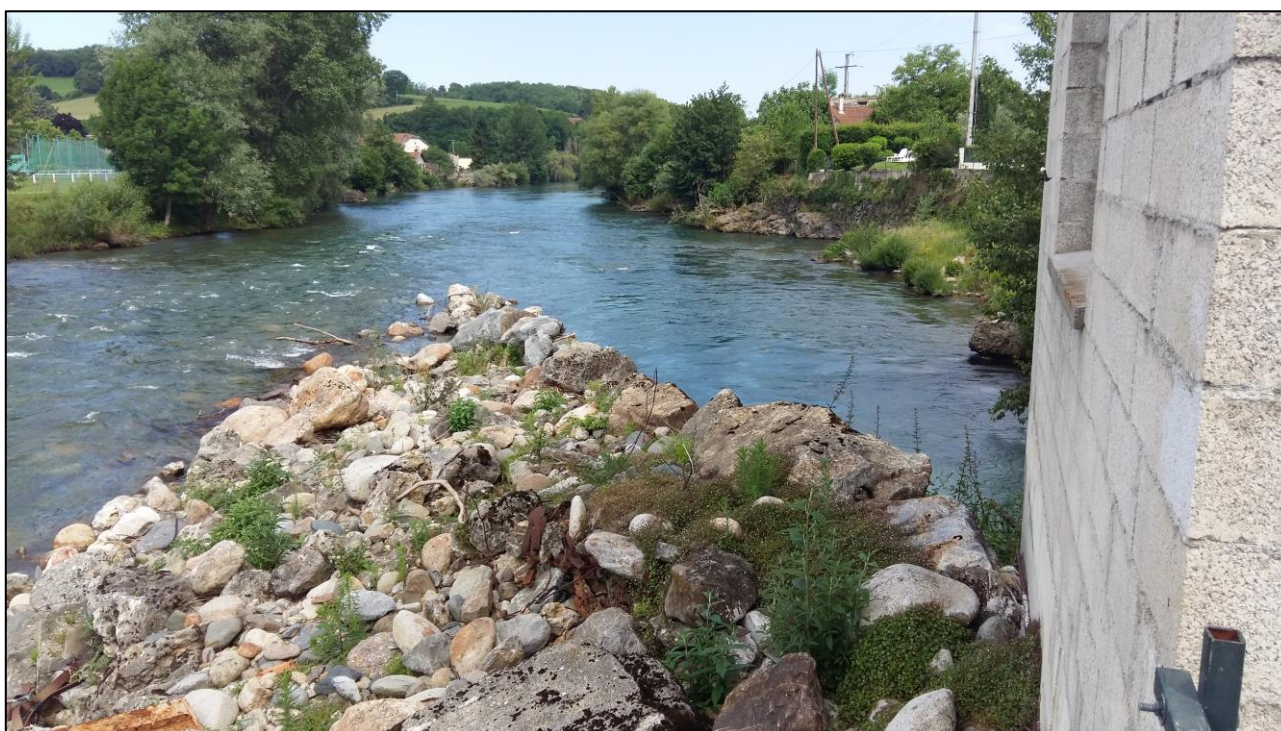
Figure 3 : Vue de l'amas rocheux en aval de la centrale
